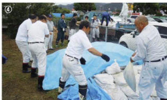
④作った土のうを現地へ運ぶため、トラックへ積み込む作業を行う ⑤越水した箇所に土のうを積む市の職員 ⑥災害対策本部を設置し、情報の収集や職員の派遣を行う ⑦漏水箇所にはシート張り工法を行って水が漏れないように補強
