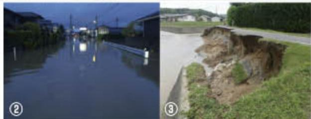
①猛烈な勢いの雨は道路を陥没させる被害などを出した(正崎地内) ②7日未明に県道岡山吉井線が冠水した(正崎地内) ③水位が上がり、削りとられた道路ののり面(西軽部地内)
