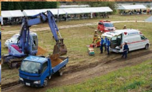
土砂の撤去をする赤磐市建設業協会
