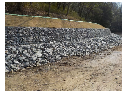
▲ 工程後 用石塊覆蓋部分
