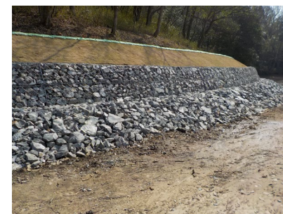
▲ 工程後 用石塊覆蓋部分
