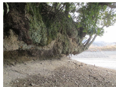
▲ 工程前 坟丘底部损坏部分
