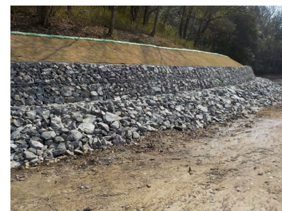
▲ 工程后 用石块覆盖部分
