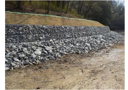
▲ 공사 후 석재로 덮은 곳
