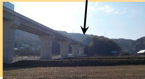
▼美作岡山道路になった土井遺跡
