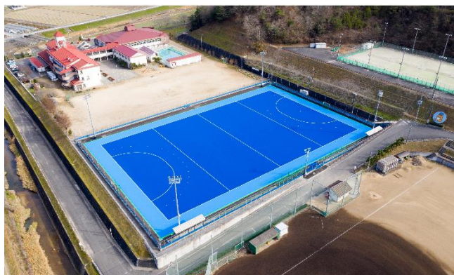
張替えが終わった熊山運動公園 多目的広場 人工芝
