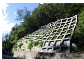
復旧完了（法面工完成）
