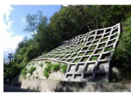
復旧完了（法面工完成）
