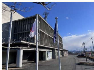
消防本部庁舎は平成25年に新築。
