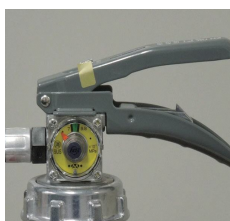
× 安全栓の脱落
